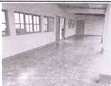
Foto 2: Imagen de la colocación de piso en el corredor de la cocina y aula de preprimaria..
