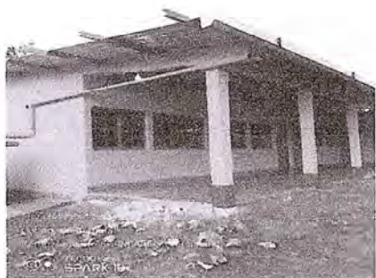
Foto 5: Se observa la aplicación de pintura en las paredes de la cocina y la instalacion de nueve metros lineales de canales
