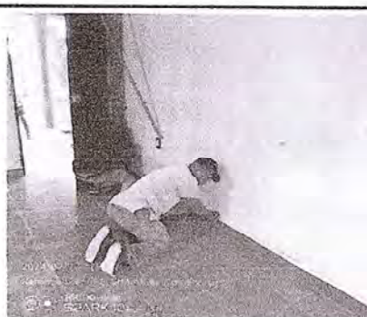
Foto 4: colocacion de socalos en el aula de preprimaria.
