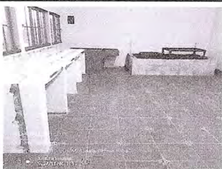
Foto 3: Fotografía de la sustitución piso en la cocina, la construcción de una mesa de concreto y un polleton.
