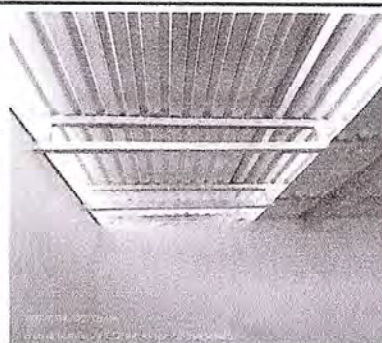
Foto 4: Se observa la elevación de una parte del techo de la cocina, como extractor de humo.
