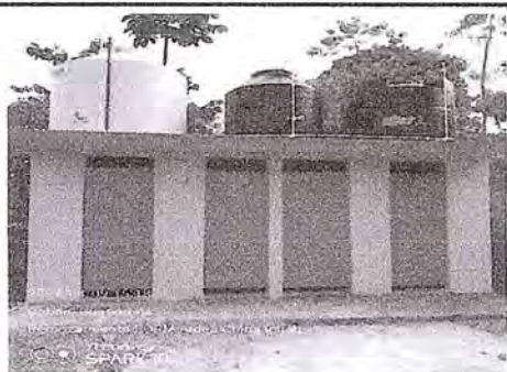
Foto 5: Se observa las cuatro puertas nuevas para sanitarios, la aplicación de pintura a las paredes, instalación eléctrica y un depósito de agua color beige Marca Rotoplas de 2500.
