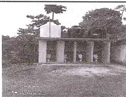
Foto 6: Se evidencia la instalación de cuatro sanitarios nuevos Marca Aldosa.
